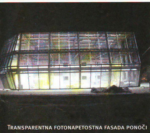
POSLOVNA STAVBA PODJETJA LIDO NA VRHNIKI S FOTONAPETOSTNO ELEKTRARNO S SKUPNO MOČJO 33 kWp, INTEGRIRANO V FASADI IN NA STREHI OBJEKTA.
